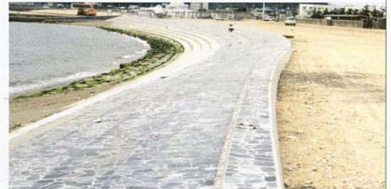
R3型 R2型(端部) ブロック上面に鉄平石を使用
