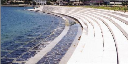
R3型 R2型(端部) ブロック上面に鉄平石を使用
