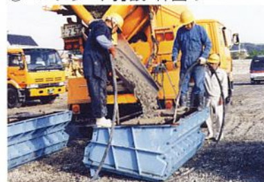
③コンクリート打設・締め
