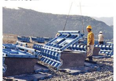
⑤型枠脱型
