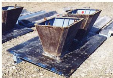
①剥離剤塗布・底板、中枠セット
