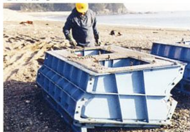
④天端均し
