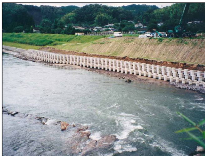
箇所名：川内川（鹿児島県） 事業主体：九州地方整備局 川内川河川事務所 型式：2t型
