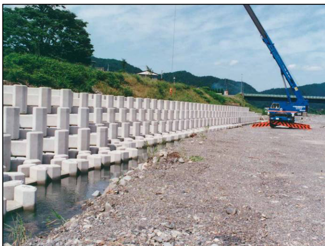
箇所名：安曇川（滋賀県） 事業主体：滋賀県 八日市土木事務所 型式：2t型
