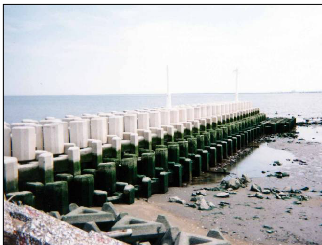
箇所名：揖斐川（三重県） 事業主体：中部地方整備局 木曾川下流河川事務所 型式：2t型
