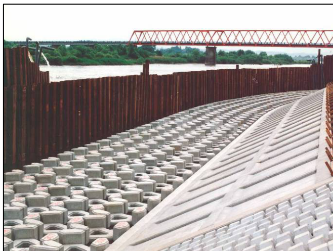
箇所名：北上川（岩手県） 事業主体：東北地方整備局 岩手河川国道事務所 型式：2t型
