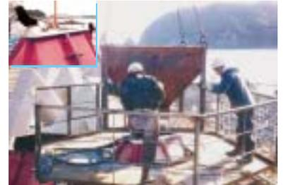
上部枠をセット後、前層まで打ち継ぎ目に注意して、天端まで打設を行う。打設完了後、ブリージング現象の終る時間に合わせてスパージングを行い、更に生コンが落ちていたら、天端面のコテ均しを行う。コテ均し終了後、養生シート等でブロックの養生を行う。
