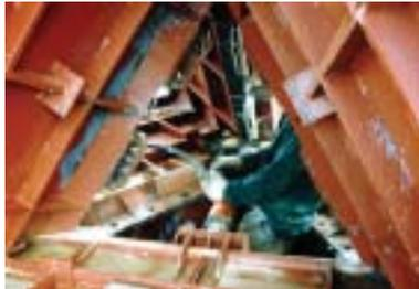
ボルト・ナットをすべて外し、脱型金具・装置を装着後、ジャッキをかける。外枠は3枚すべて剥離してから1枚ずつ外す。
