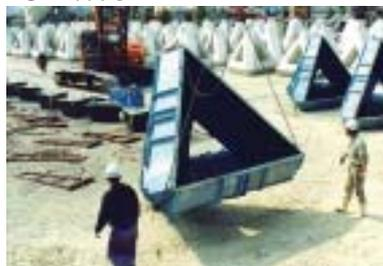
外枠の組立て中は仮締め程度にし、3枚を組み合わせた時点で、シノ棒等を用い型枠の合せ具合を、確かめながら本締めを行い、型枠を倒立させる。
