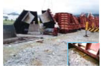
外枠の組立て中は仮締め程度にし、3枚を組み合わせた時点でシノ棒等を用いた型枠の合せ具合を確かめながら本締めを行う。
