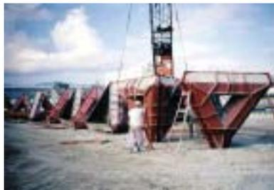
型枠脱型強度が発生したことを確認してから、中枠を脱型する。支柱を外す際はワイヤーを必ず所定の位置に3点かけ、型枠に荷をかけた状態で、速やかに外す。
