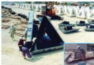
ブロック製作は水平強固な地盤で行うこと。分割されている型枠は1枚ものに組立て、剥離剤をしっかりと塗布する。
