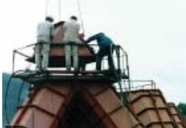
④の打設完了後、上部枠をセットする。作業用足場は、安全性と作業性を考慮し、適切な足場を用意する。
