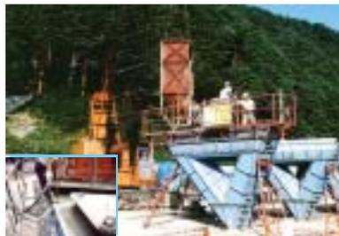
打設は、天端面まで一気に打設することは避け、3方向より均一に投入する。また、バイブレーターも3方向より均一にムラなくかけ、十分に締め固める。
