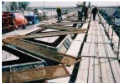
倒立後、作業用足場を組立て、中枠をセットする。打設前には、支柱・足場等が安全である事を確認した後、打設を行う。
