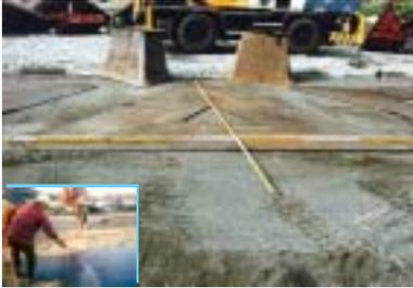
ブロック製作は水平強固な地盤で行うこと。分割されている敷板は、1枚もの組立てた後、中枠をセットし、剥離剤をしっかりと塗布する。※60・80t型は敷板にクランプをセットする。
