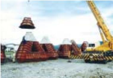
所定の型枠脱型強度が発生したことを確認後、上部枠を脱型する。
