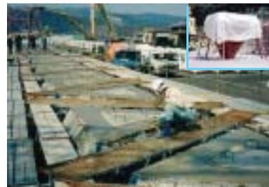
打設完了後、ブリージング現象の終る時間に合せてスペーシングを行い、更に生コンが落ち着いてから、天端面のコテ均しを行う。コテ均し終了後、養生シート等でブロックの養生を行う。
