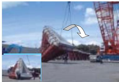
転倒作業を行う際は、周辺の安全に気をつけて行う。型枠内にコンクリートが入っている状態での移動は、極力避け、衝撃を与えないように、ゆっくり転倒させる。
