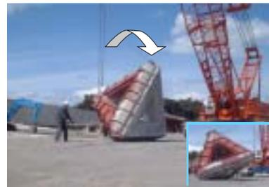
ワイヤーを掛け直し、2回目転倒。衝撃を与えないように、ゆっくりと静かに起こし、着地させる。必ず型枠が地面に接した状態（支点にして）で行う。この作業での横持ち移動は、絶対に避けること。
