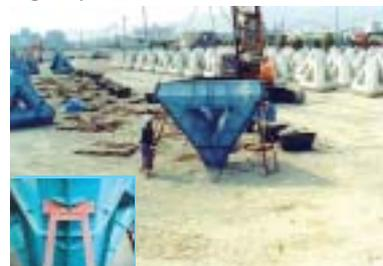
倒立用の支柱は、バランス良く地盤にしっかりと固定させ、チェーン（6~25t）を型枠と支柱に、たるみなく掛け、天端面を水平にセットする。
