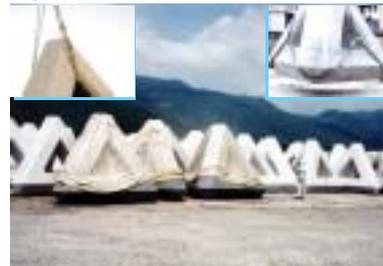
転置強度が発生した事を確認し、転置作業を行う。転置は、中空部を利用して玉掛けを行うか、もしくは、スリングベルトを利用して行う。転置・仮置後、養生シート等でブロックの養生を行う。
