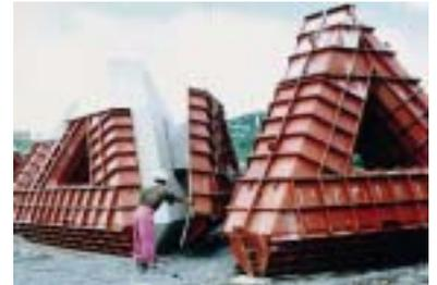
脱型した型枠は、ケレン棒・ウエス等で清掃した後、剥離材を塗り、次のコンクリート打設に備える。
