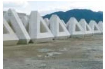
ブロック転置は、中空部を利用して玉掛けを行うか、もしくは、スリングベルトを利用して行う。転置・仮置後、養生シート等でブロックの養生を行う。
