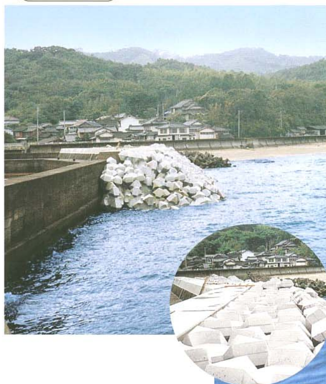
■引坂漁港 熊本県五和町 消波工・3t型
