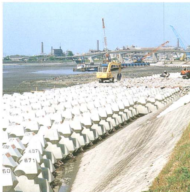
■熊本県 南川 建設省八代工事事務所 根固工・4t型
