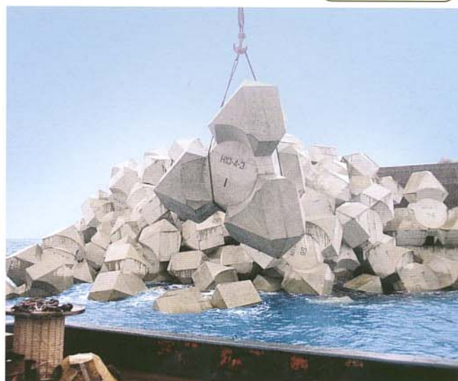
■窪津漁港 高知県土佐清水土木事務所 消波工・60t型
