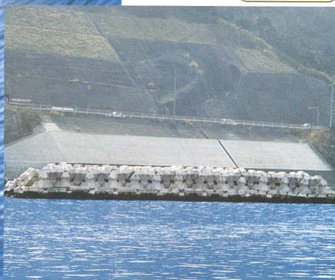
■上総湊港海岸 千葉県木更津港湾事務所 離岸堤・5t型
