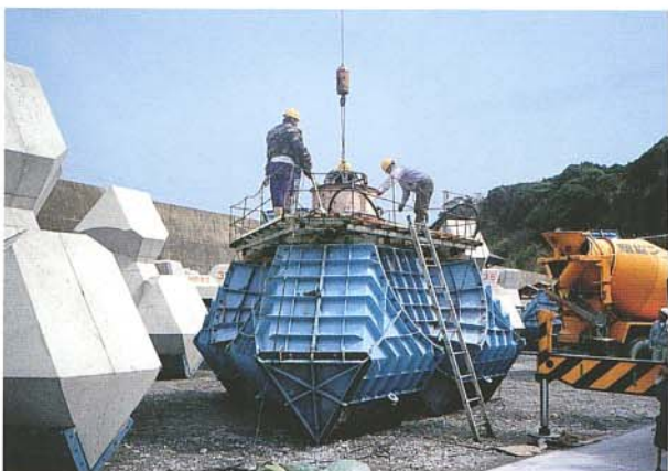
5 生コンの打設 ①
