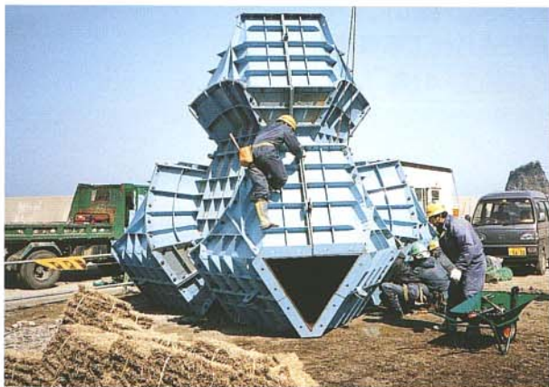
3 外枠の組立て ②
