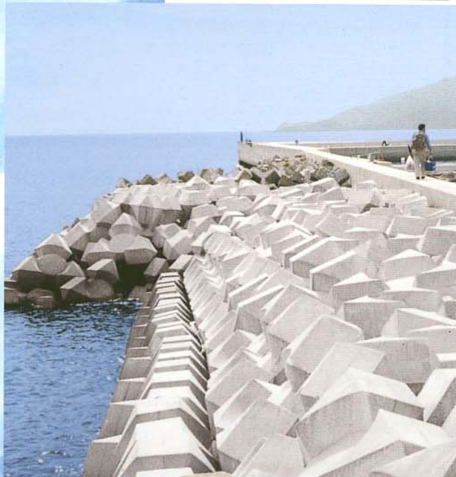
■大多尾漁港 熊本県天草水産事務所 消波工・4t型
