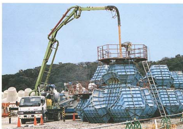
6 生コンの打設 ②
