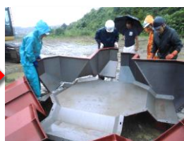
②側枠の取付(1)
