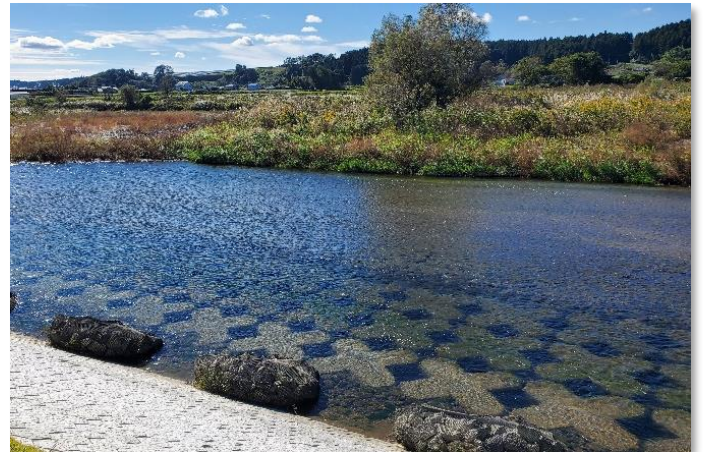
簗川 4t 型・根固工／栃木県 大田原土木事務所
