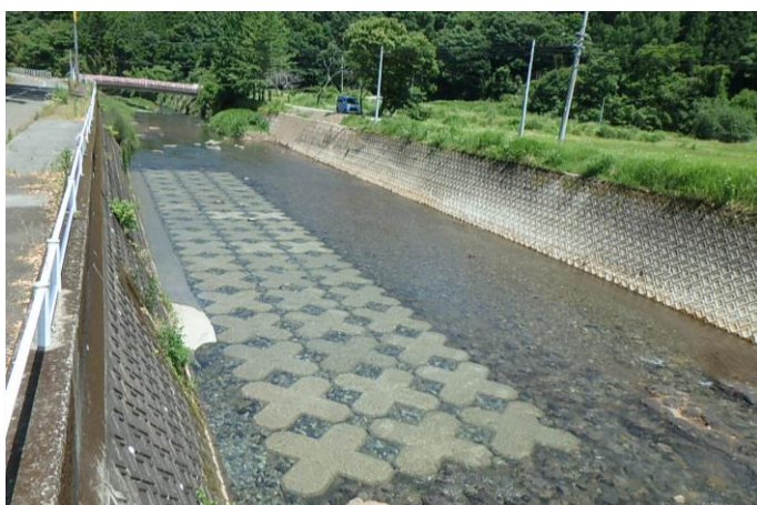
緒方川 4t 型・根固工／大分県 竹田土木事務所
