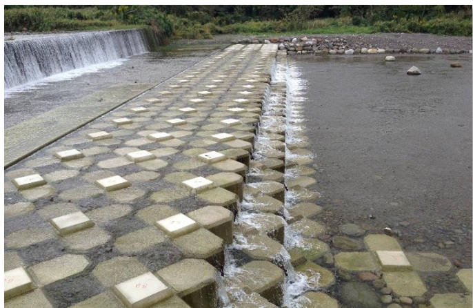
阿弥陀川 4t 型・護床工／鳥取県 西部総合事務所
