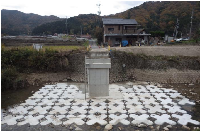
高大地橋 2t 型・橋脚根固工／広島県 安芸高田市役所
