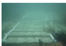
②海底設置状況
