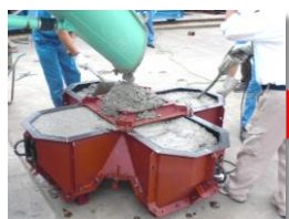
①打設～締固め
