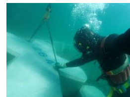
水中据付の様子
