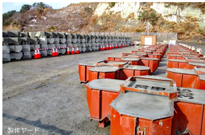
野田漁港 2t 型・機能強化(被覆工)／岩手県 県北広域振興局
