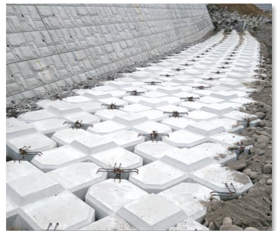
玖珠川 根固工 6t 突型 大分県 日田土木事務所
